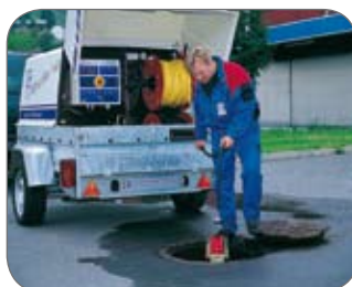
Assainissement des canalisations
